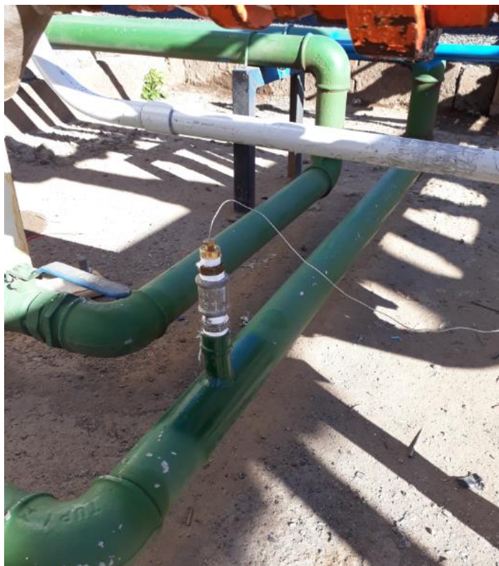
Figura 7 – Termostato de Segurança
