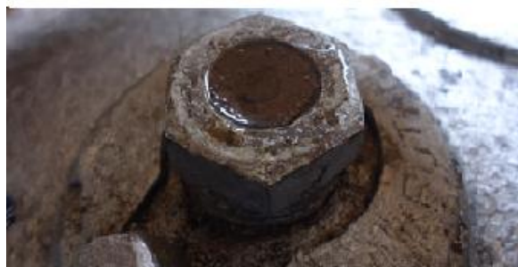
Ausência de Vazamento
