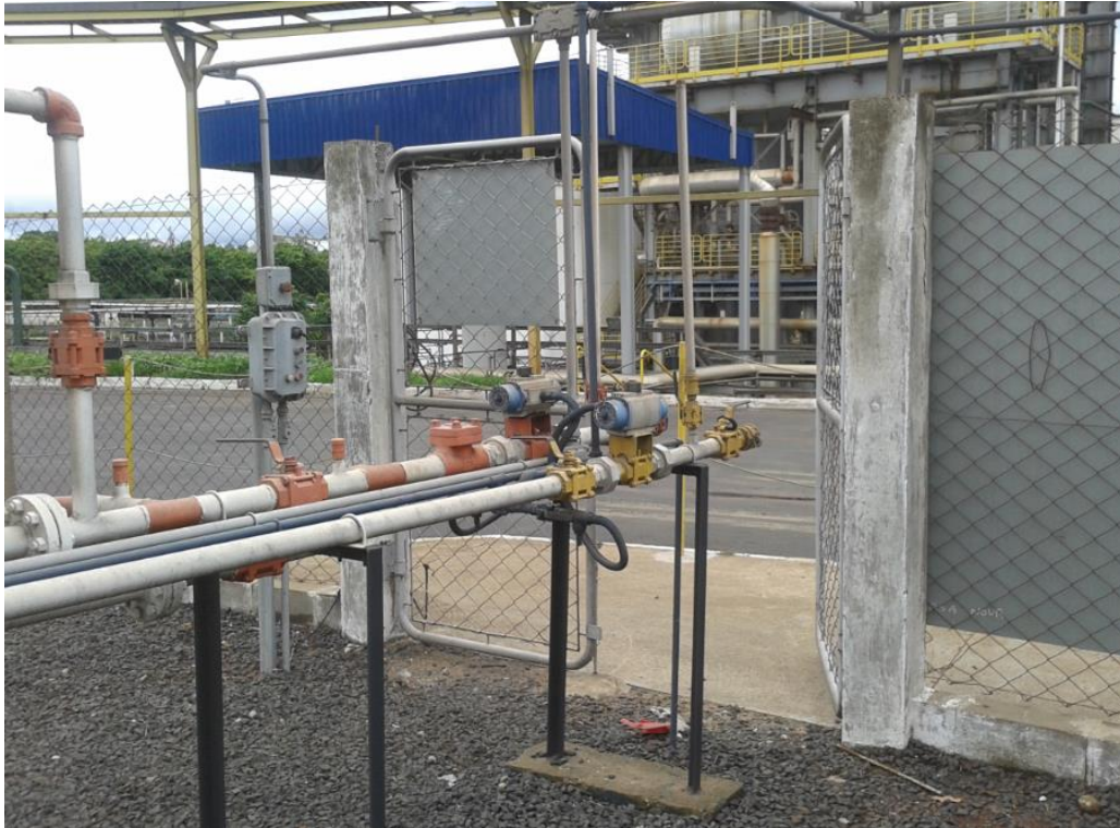
Figura 7 – Instalação de atuadores pneumáticos na válvula de bloqueio no transvaso de GLP
