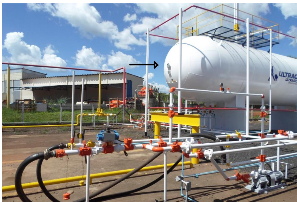
Figura 1 – Exemplo de Conjunto Magnetron (medidor magnético do nível de GLP)
