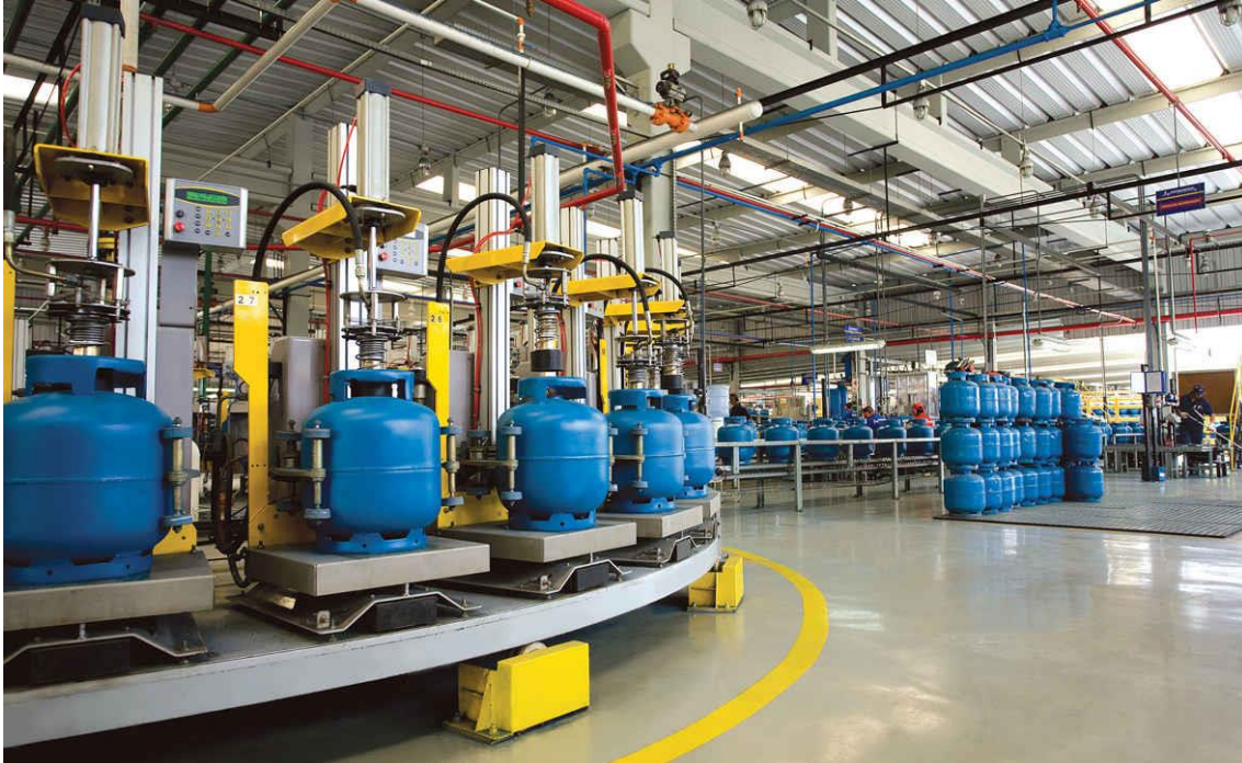
Figura 01 - Centro Operativo Ultragaz (Unidade Operacional).
