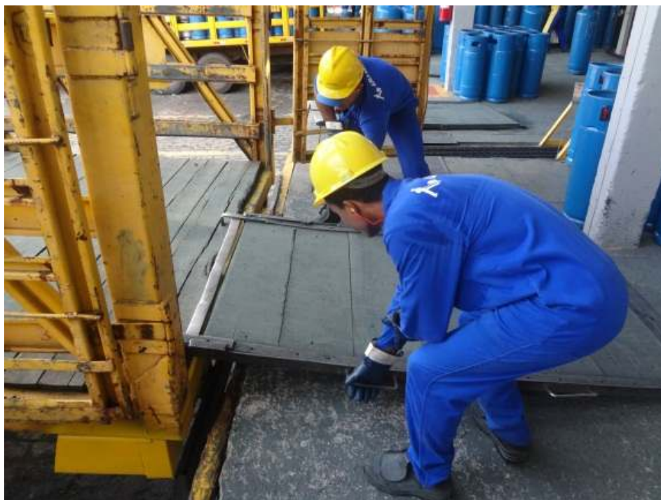
Foto 6 – Rampa sendo colocado na carroceria da carreta
