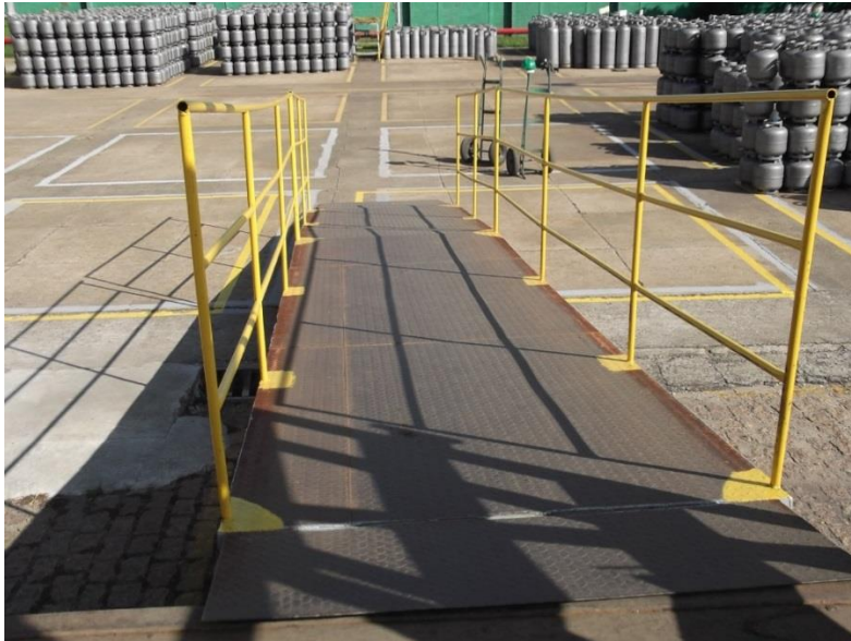
Figura 11 – Rampa móvel construída
