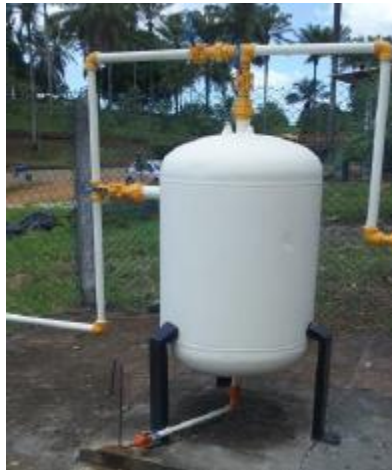
Figura 5: Separador de pesados.
