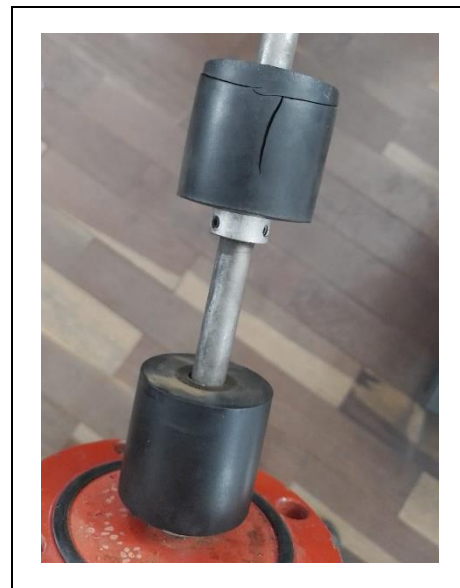
FIGURA 2 - BOIA DE NÍVEL SUPERIOR TRAVADA NA POSIÇÃO INICIAL DEVIDO A SOBREAQUECIMENTO.
