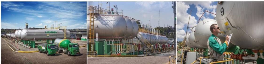
Centro Operativo Liquigás (Unidade Operacional)
