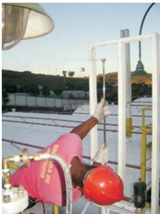
Figura 07: Emissão de Gás LP no processo de medição do nível do reservatório
