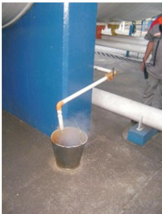
**Figura 12: Emissão de GÁS LP no processo de drenagem de fundo dos reservatórios**
