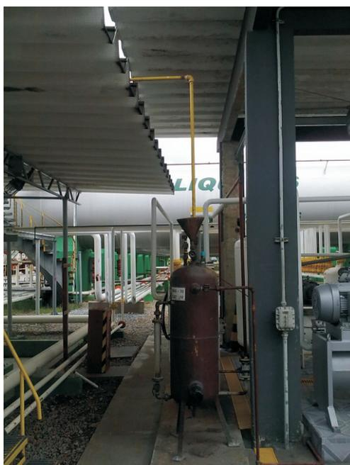
**Figura 23:** Vaso de óleo lubrificante
