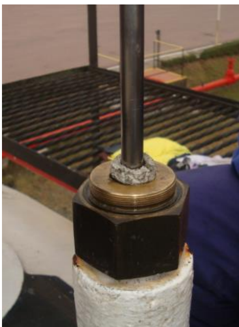
Foto 7: Manutenção das 3 gaxetas de fibra acrílica em PTFE
