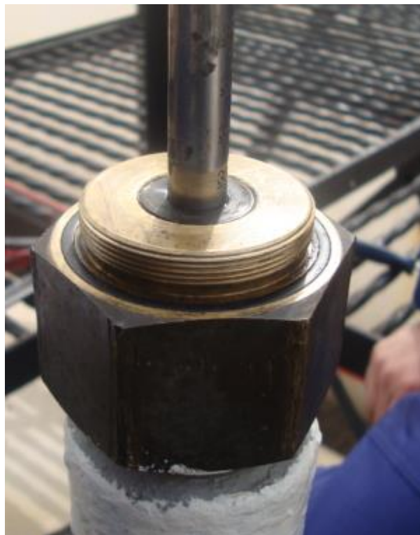
Foto 9 – Anel de Vedação Instalado
