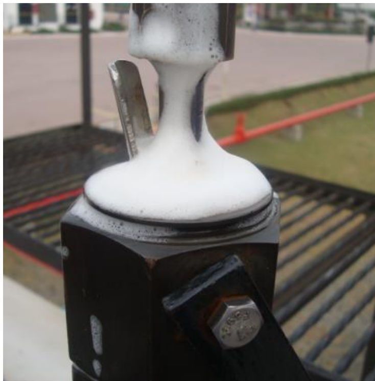
Foto 10: Teste de Estanqueidade (somente sabão)
