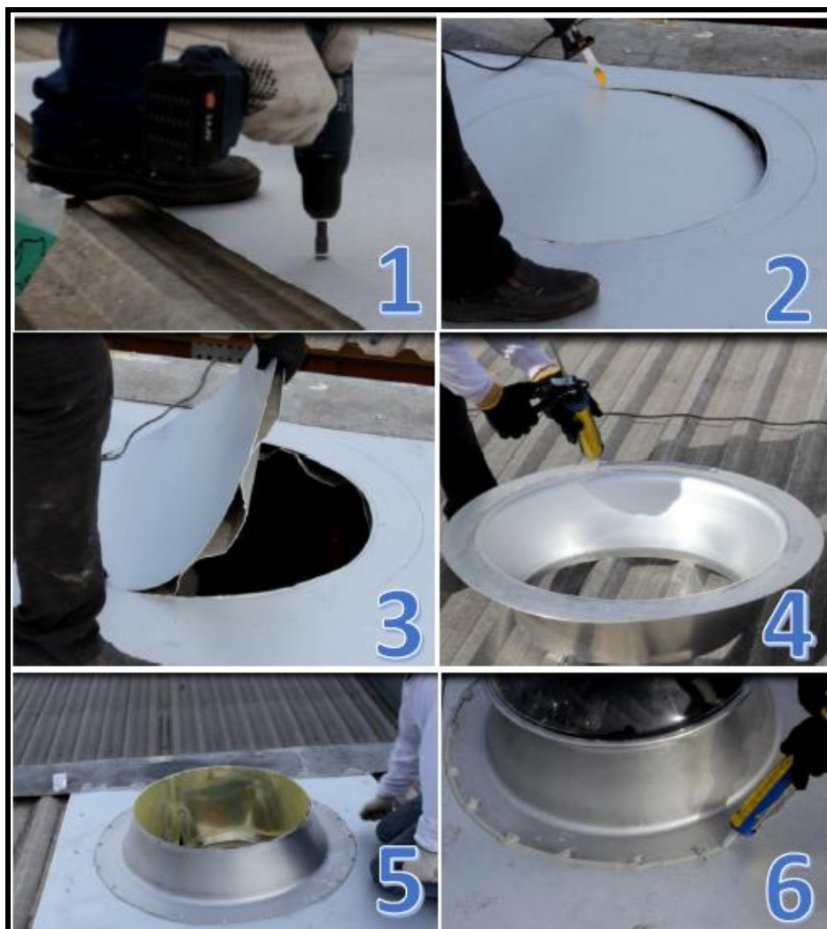
Figura 4: Etapa de Montagem da Luminária Solar
