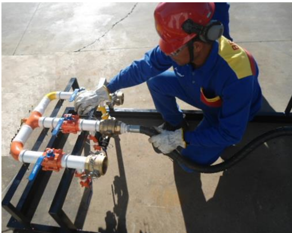
Figura 6 – Conexão de mangote de GLP no protótipo.
