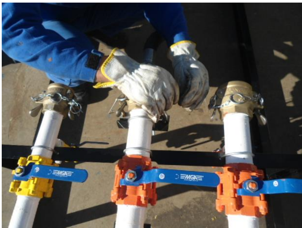
Figura 7 – Colocação de Pino trava no acoplador de mangote de GLP.
