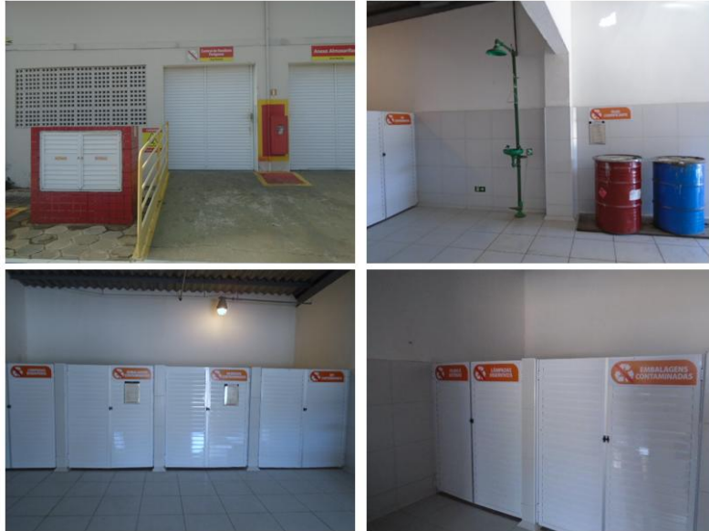
Figura 12: Central de Resíduos Classe I.
