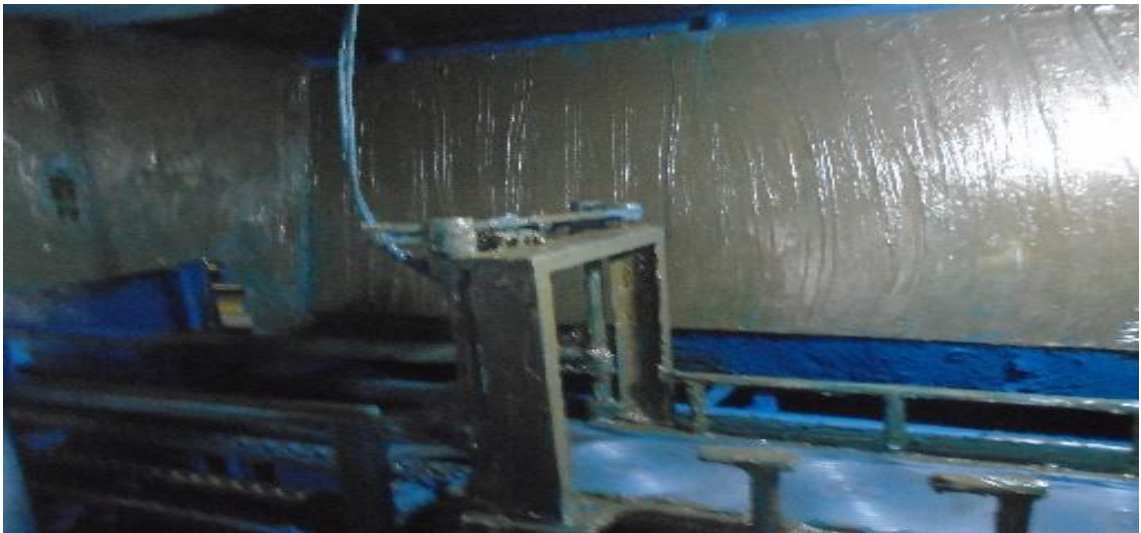
FIGURA 5: APLICAÇÃO MANUAL DE GRAXA DE PROTEÇÃO
