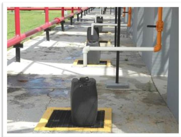
Foto 01. Recipiente para coletar o efluente da drenagem
