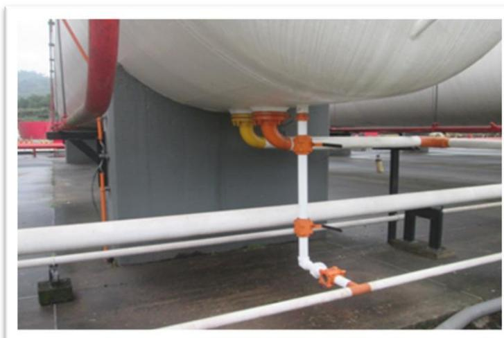
Foto 9 – Passagem de GLP líquido do tanque ao término da operação
