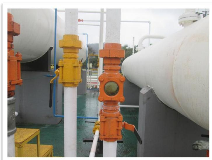
Foto 8 – Passagem do GLP líquido arrasta a parte oleosa, permitindo o término da operação
