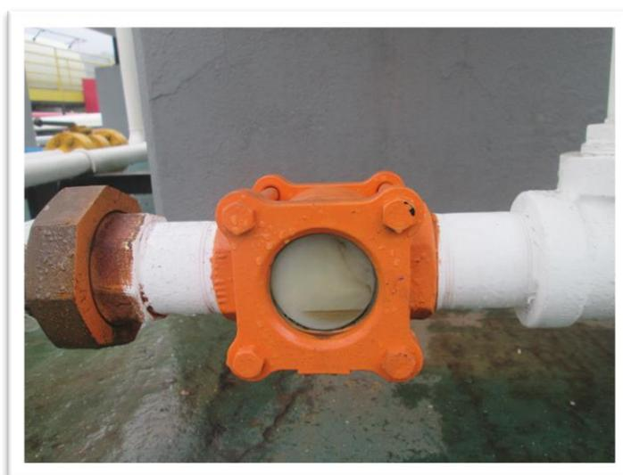
Foto 4 – Visor do dreno (névoa indica a passagem do GLP)
