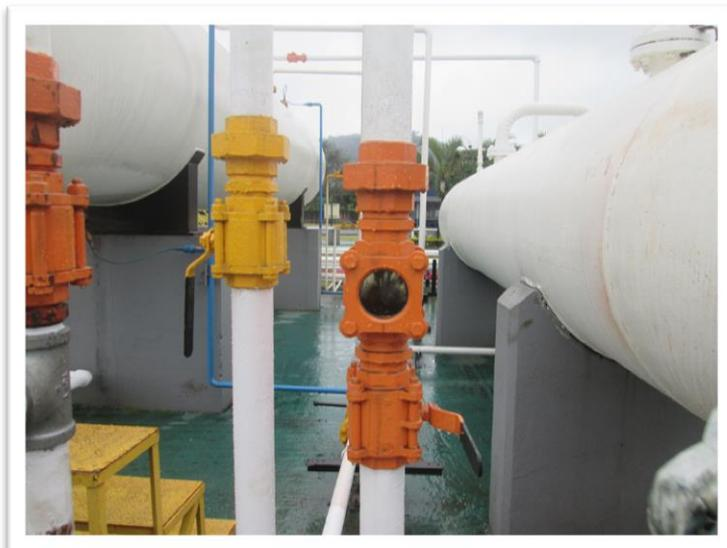
Foto 7 – Momento da passagem de GLP na fase Líquida para o tanque de decantação
