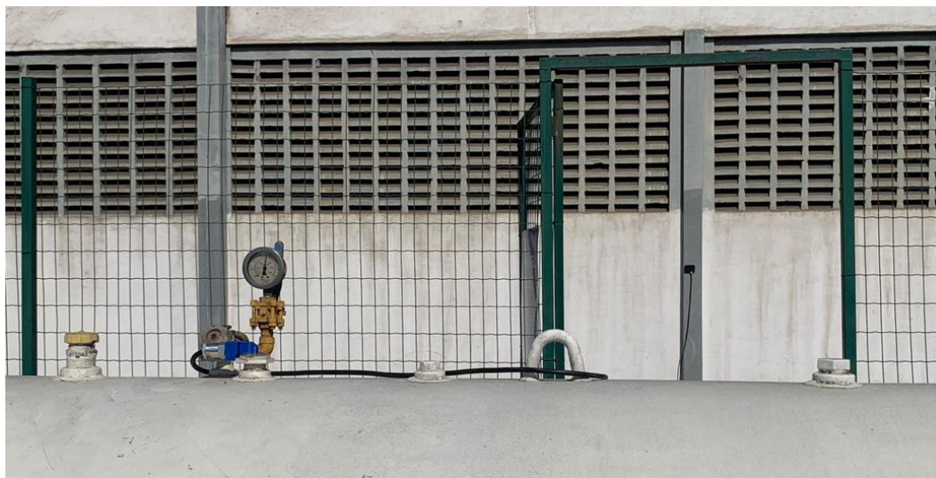
Figura 20 – Sensor acoplado e caixa dados do sistema de telemetria IoT modelo X
