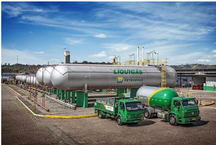
Figura 1: Centro Operativo de Capuava – Fonte: Liquigás Distribuidora S.A
