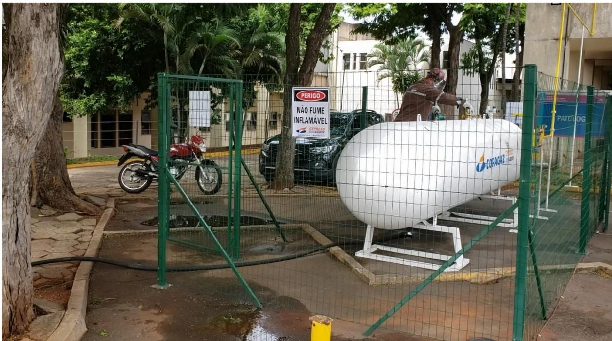
*Imagem 8. Reservatório de armazenamento tipo tanque de 2 toneladas de "GLP - Gás Liquefeito de Petróleo"*
