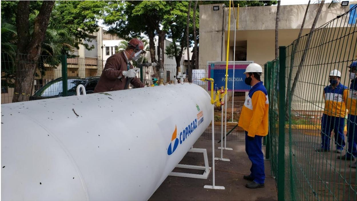
*Imagem 9. Reservatório de armazenamento tipo tanque de 2 toneladas de “GLP - Gás Liquefeito de Petróleo”*
