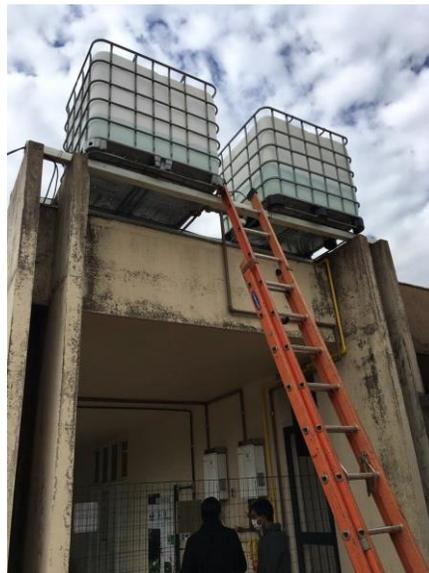
**Imagem 12. Reservatórios de água do tipo bombona d'água**
