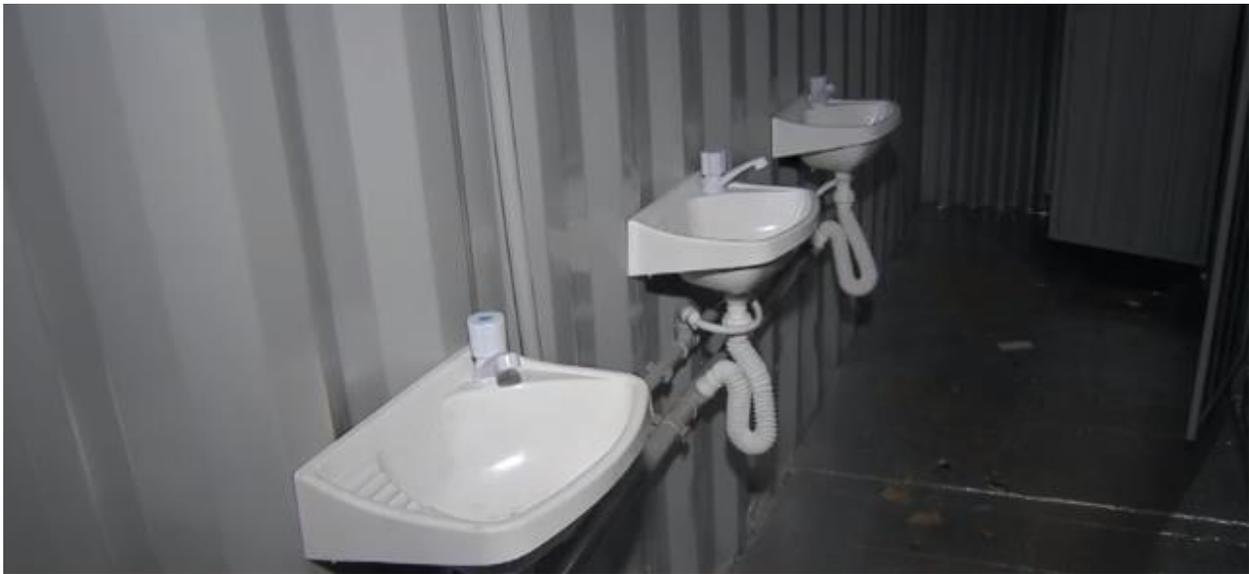
*Imagem 6. CONTÊINERS de higienização equipados com lavatórios e torneiras de água quente*
