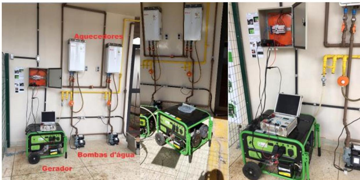
**Imagem 3. Localização do sistema de "Gerador de Energia GLP - Greengear GE-7000 AS"**
