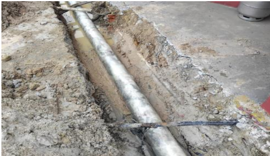
Figura 21 - Tubulação com revestimento sendo instalada enterrada
