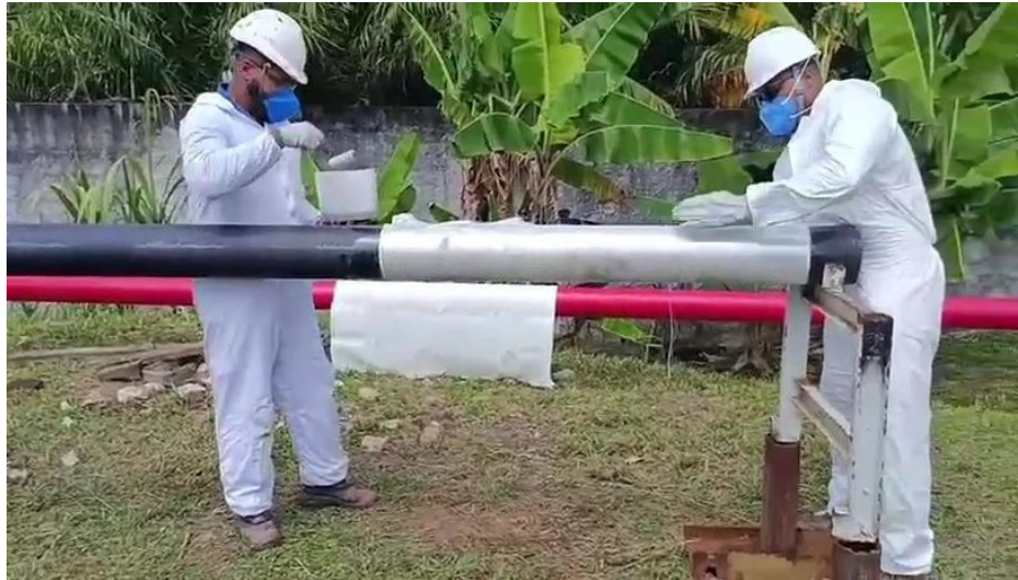
Figura 16 - Tecido Biaxial 1808 aplicado
