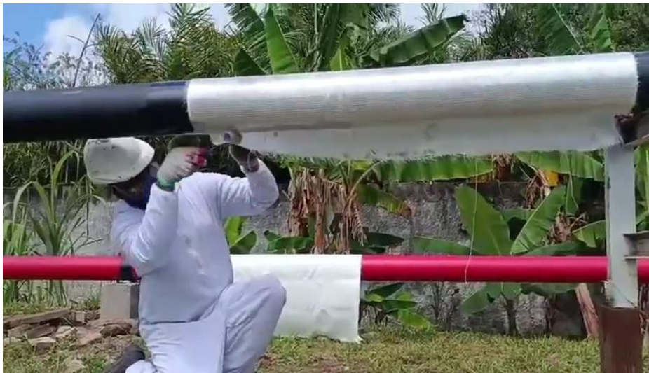
Figura 17 – Aplicação da resina no tecido
