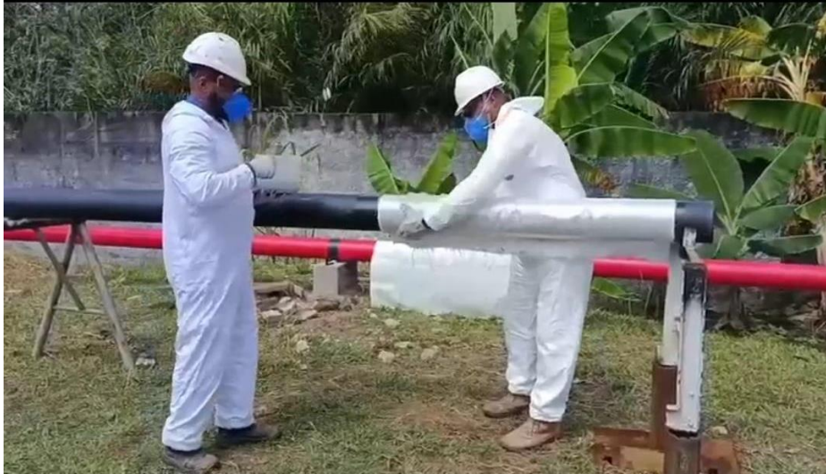
Figura 15 - Encamisamento da Tubulação
