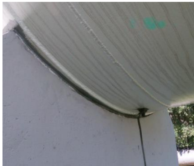
Figura 3 - Aplicação do primer (PU40)
