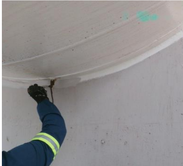
Figura 6 - Pintura de acabamento (PU40)
