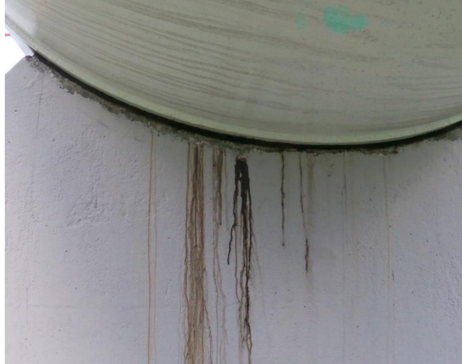
Figura 2 - Abertura de cavidade (PU40)
