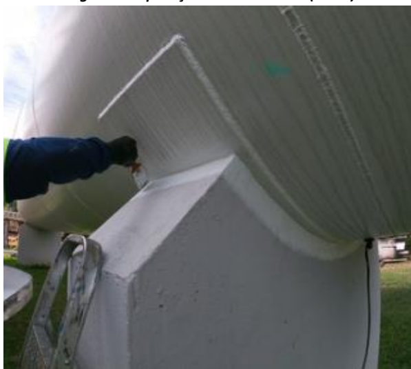
Figura 5 - Aplicação do elastômero (PU40)
