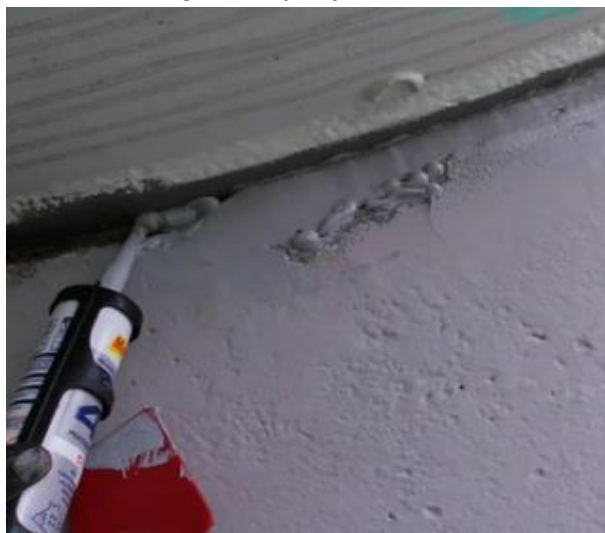
Figura 4 - Aplicação do PU40
