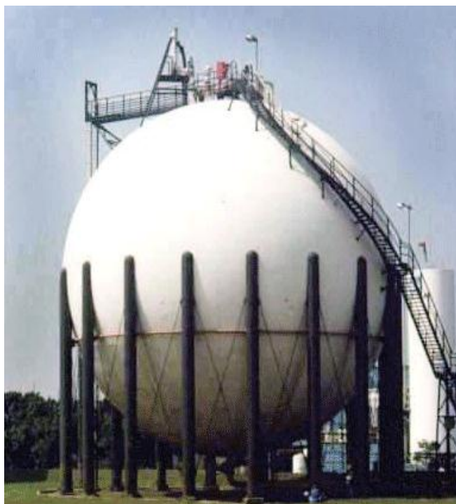
Figura a – Esfera aguardando inspeção
