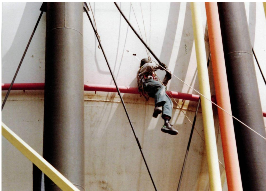
Figura 2 - Colocação dos sensores na altura da linha do equador
